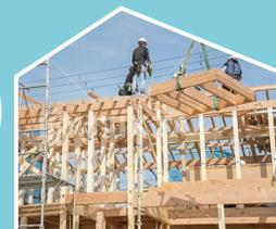
建て方とは、現場で主要な柱や梁などの構造材を組み立てる工程のこと。木材がクレーン車で吊り上げたりと、一気に現場が活気づいてきます。
